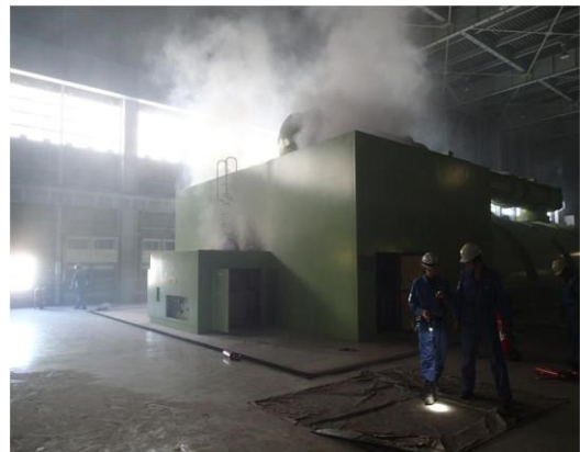
4号機：タービン出火状況
